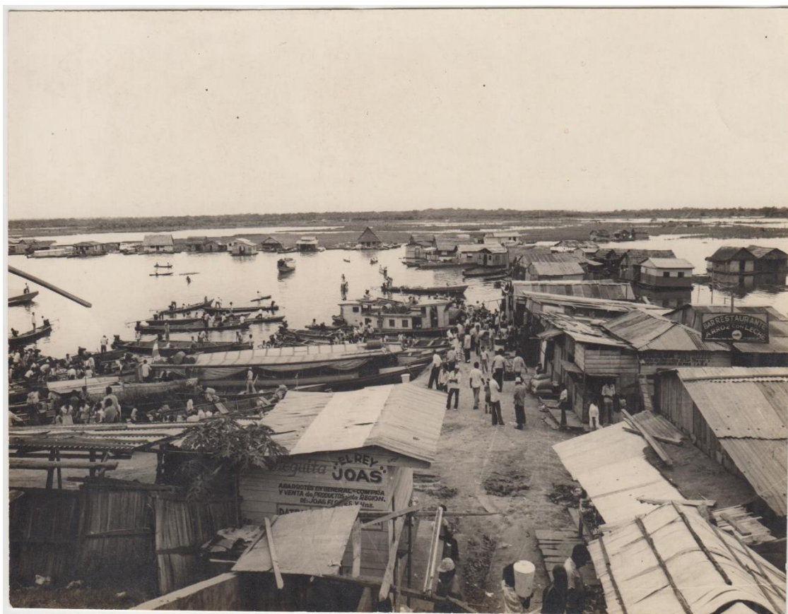
Vista del puerto
