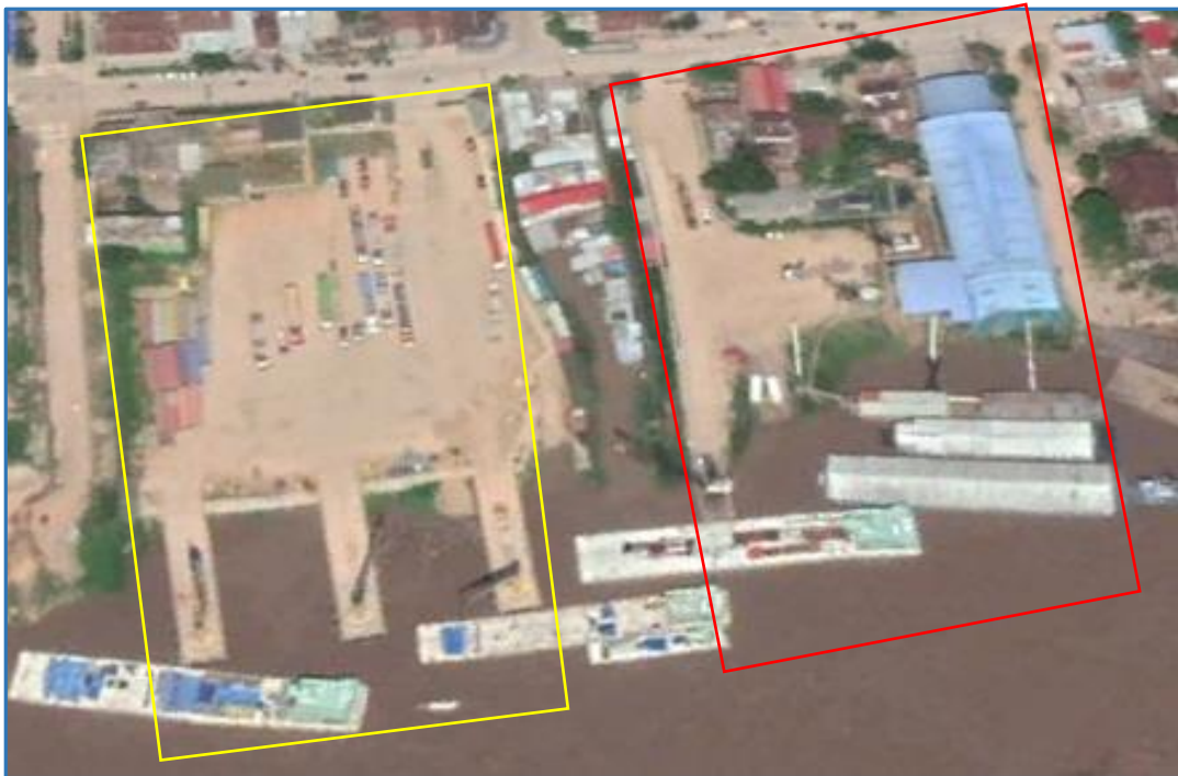
Imagen aérea de los dos principales terminales portuarios privados en el puerto de Pucallpa (Terminal portuario de LOGISTICA PERUANA DEL ORIENTE S.A., y el terminal portuario fluvial TRANSTOTAL LOGISTICA SELVA S.A.C.
