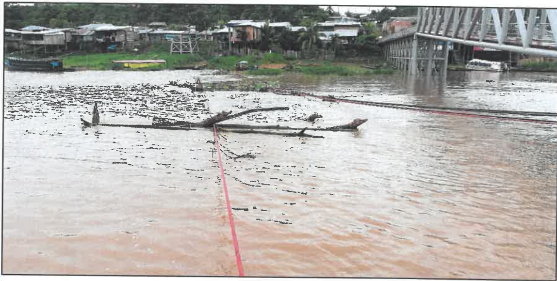
Figura 4.1-5: Muelle en la localidad de Nauta con anclaje a tierra (diciembre 2018). Fuente: Trabajos de campo
