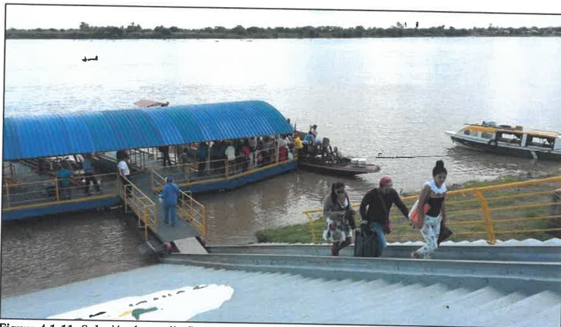
Figura 4.1-11: Solución de muelle flotante deslizante.
