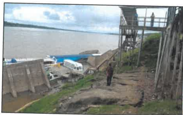
Figura 3.1-2: Riberas de la localidad de Nauta, se observa embarcadero metálico de estructura fija acondicionada en la parte baja con estructuras de madera y pontón flotante.
