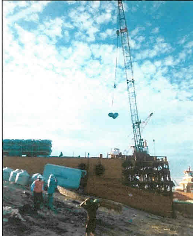
Vista de la atención de carga por grúa en Henry
