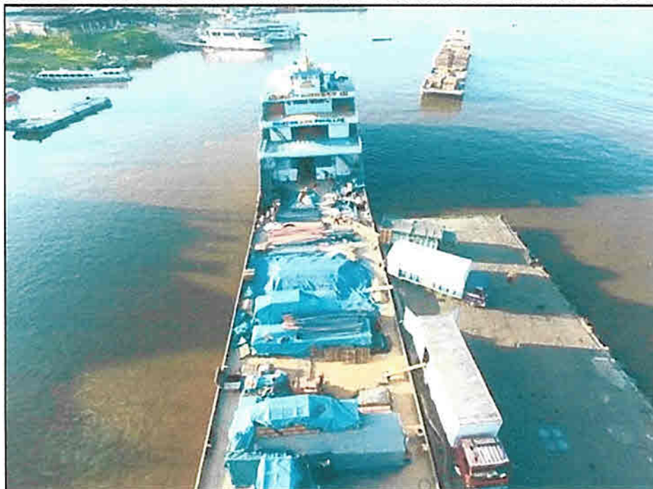
Vista de la atención de una nave en las condiciones actuales en ENAPU
