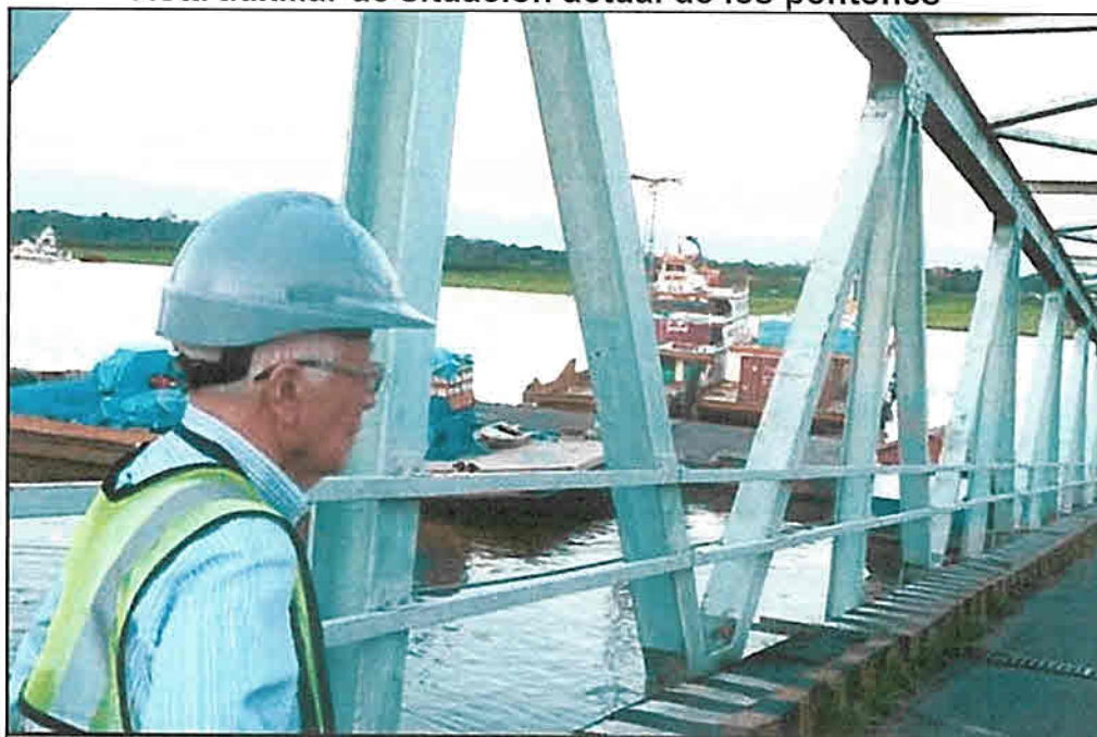
Inspección de las obras de río
