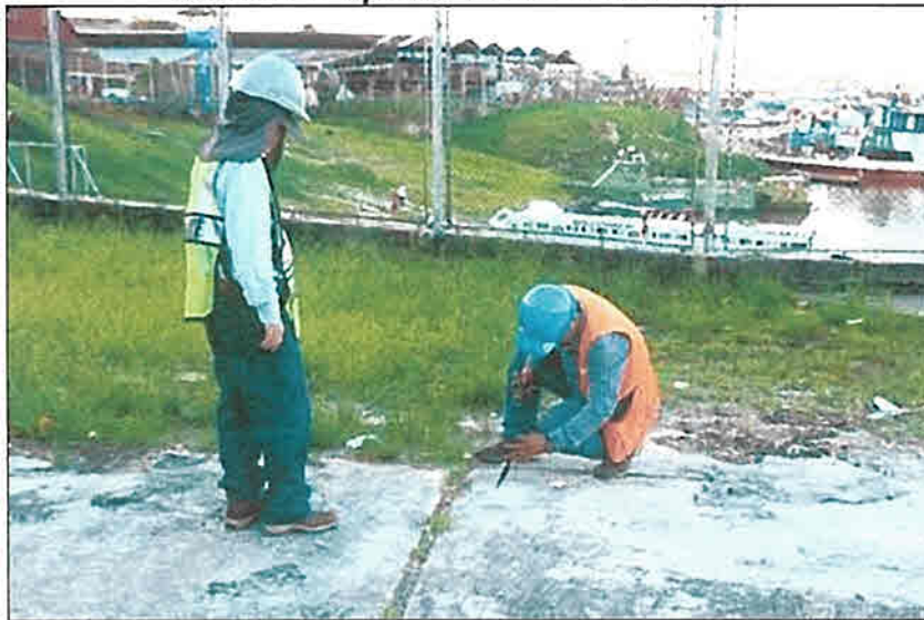
Visita de Inspección en el terminal
