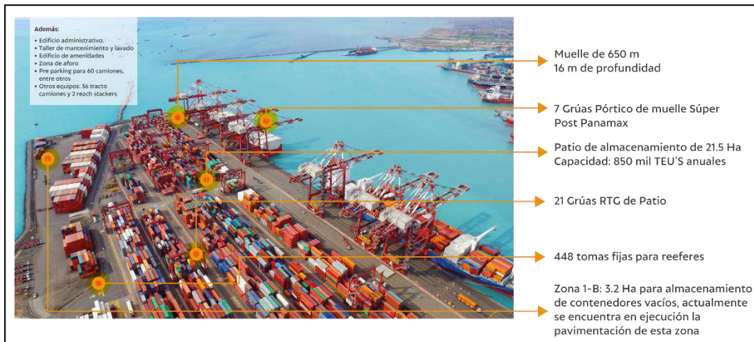
Figura 2. Terminal de Contenedores Muelle Sur: Infraestructuras
