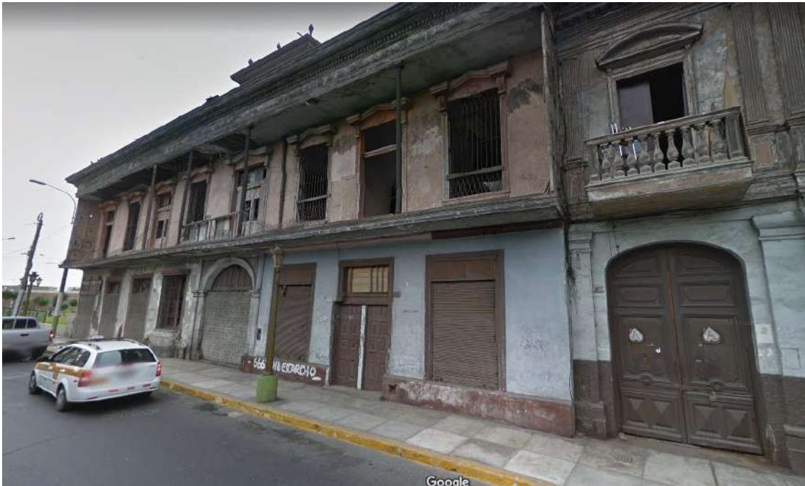
Figura 158. Vista de fachada
