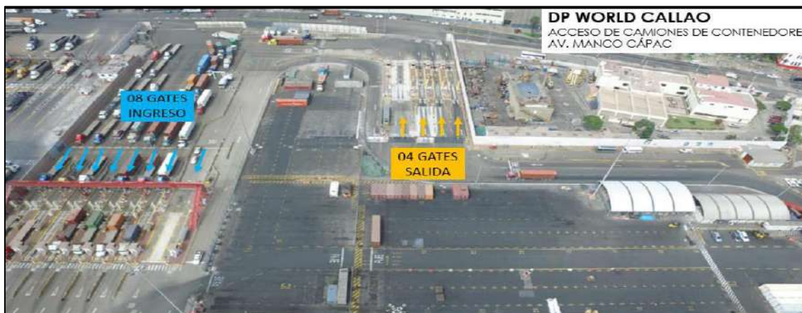
Figura 114. Antepuerto del Terminal Portuario de DPWC
