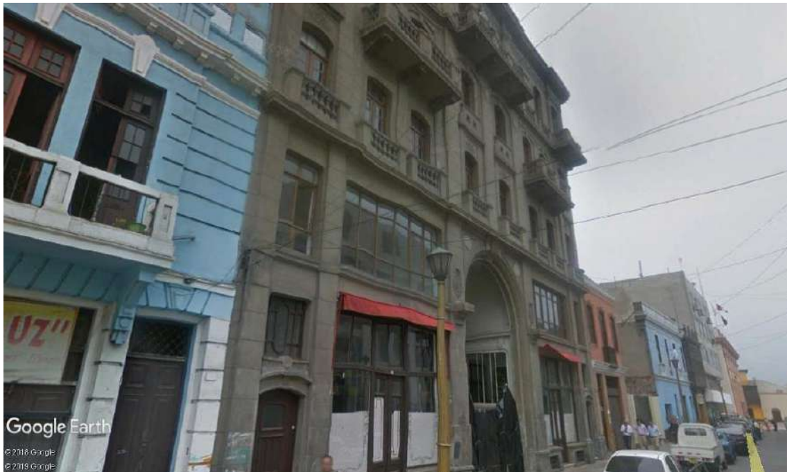
Figura 151. Vista de fachada de edificio Ronald
