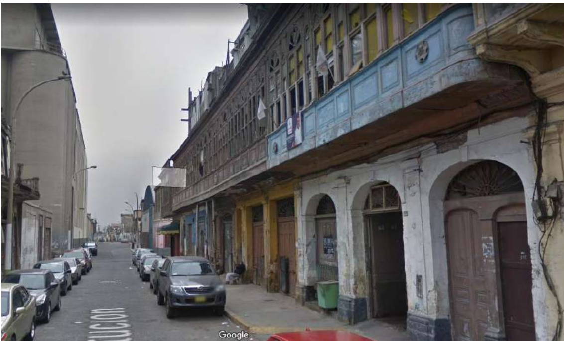
Figura 155. Vista de fachada
