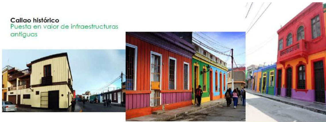
Figura 96. Callao histórico: puesta en valor de infraestructuras antiguas
