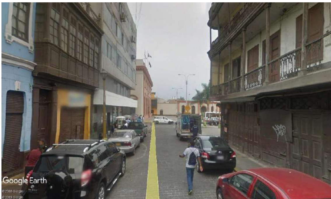
Figura 152. Vista de fachadas con balcones
