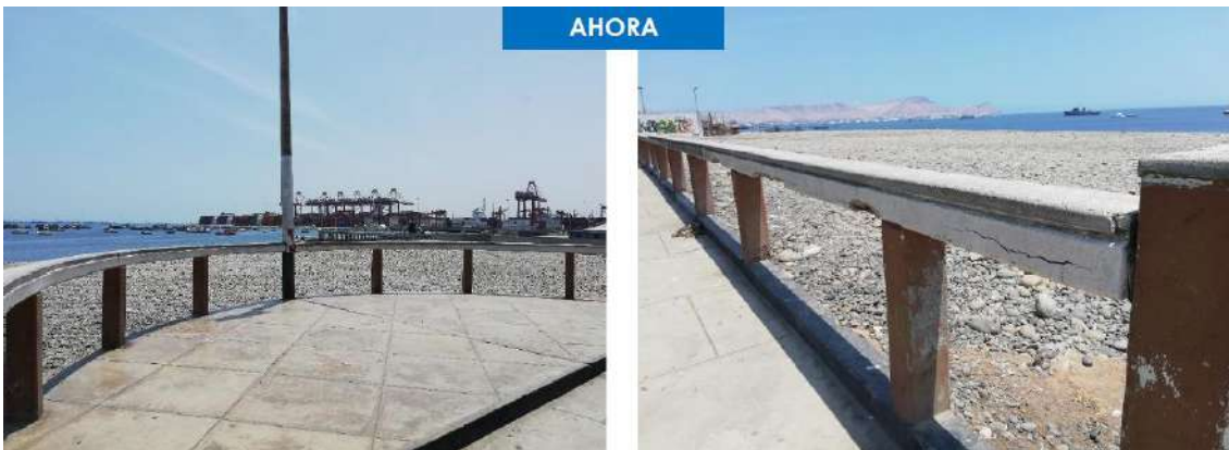
Figura 93. Remodelación y rehabilitación del malecón del Callao
