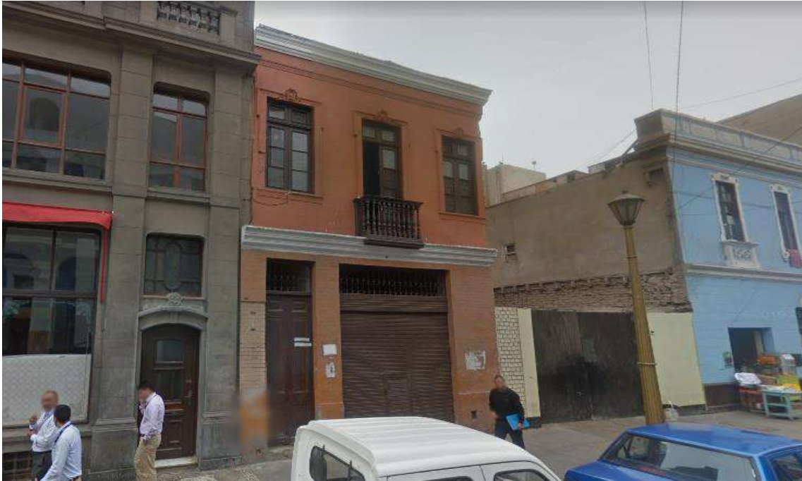
Figura 153. Vista de fachada
