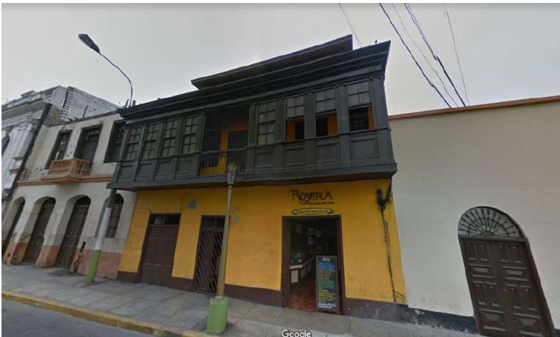
Figura 157. Vista de fachada
