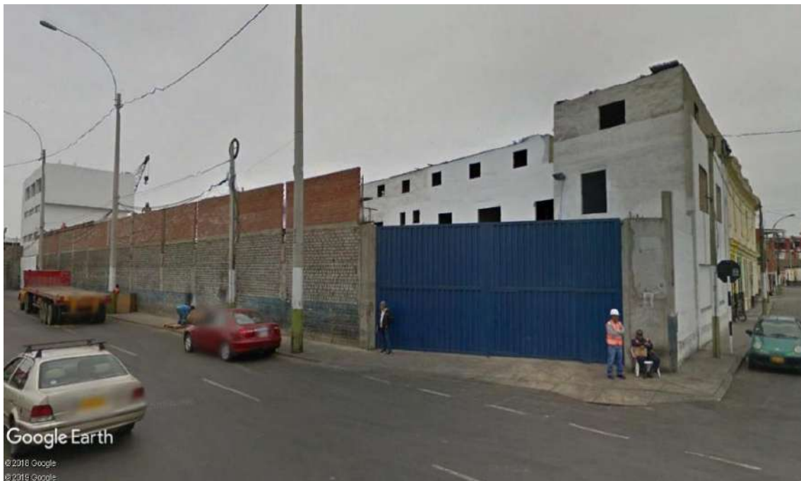
Figura 149. Vista del jirón Manco Cápac cuadra 5
