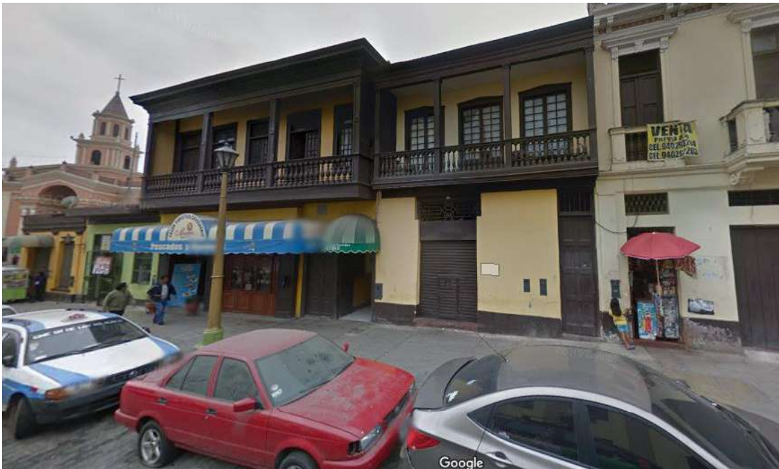
Figura 154. Vista de fachada
