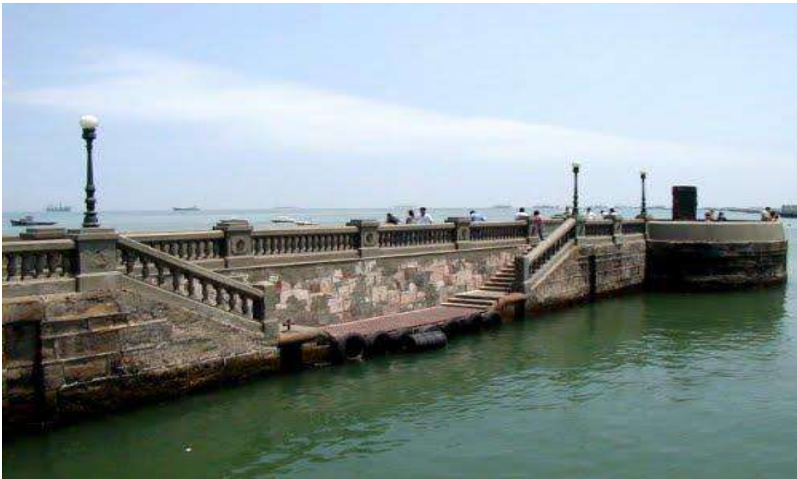
Figura 146. Vista del muelle
