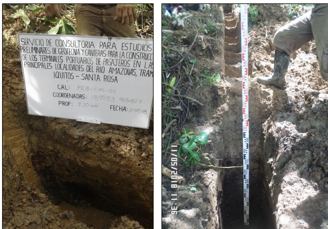
Figura 3.2-23: Excavaciones de las calicatas, C-1-PEB Fuente: Elaboración propia. (Mayo 2018).
