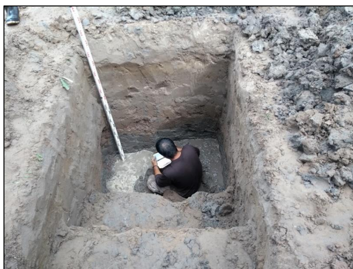
Figura 3.2-34: Excavación de calicata. C-3-SAR. Fuente: Elaboración propia. (Mayo 2018).
