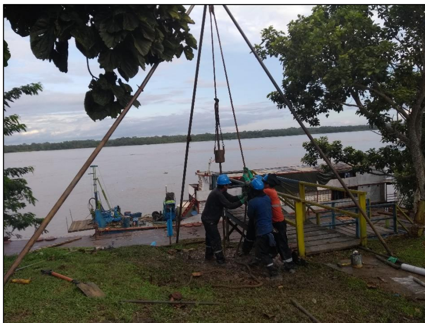
Figura 3.2-16: Ensayo de penetración dinámica, SPT-4-IND Fuente: Elaboración propia. (Mayo 2018).
