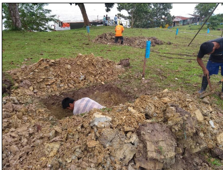
Figura 3.2-18: Excavaciones de las calicatas, C-2-IND y C- 3-IND Fuente: Elaboración propia. (Mayo 2018).
