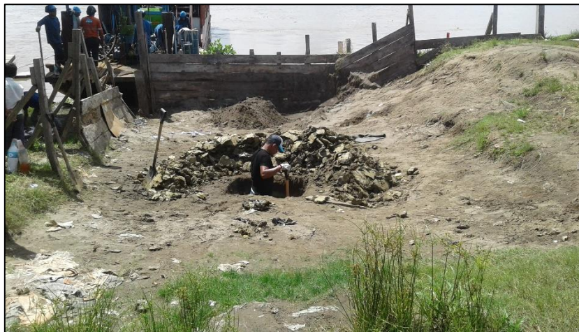
Figura 3.2-26: Excavación de calicata. C-1N-SPA Fuente: Elaboración propia. (Mayo 2018).
