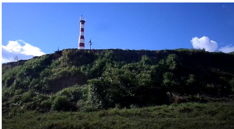
Figura 3.1-7: vista de zona de deslizamiento con abundante cobertura vegetal.
