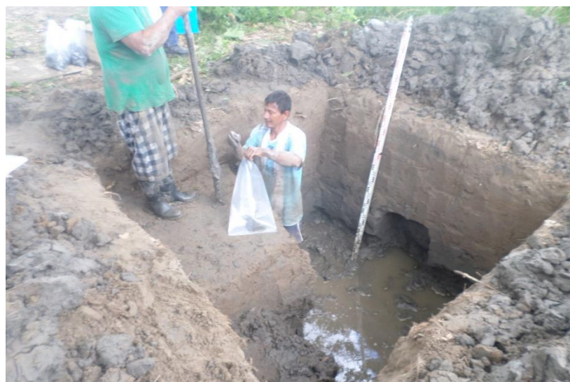
Figura 4.1-66: Excavación de la calicata 02, con ayuda de una barrena manual para llegar hasta los 3.00m de profundidad.
