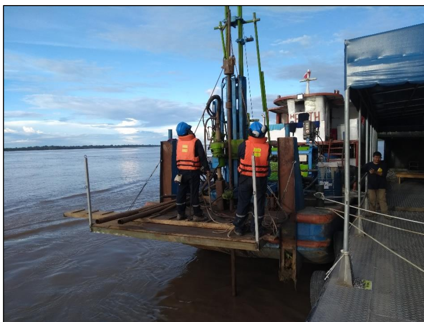
Figura 3.2-28: Ensayo de penetración estándar SPT, SPT-3-CAB Fuente: Elaboración propia. (Mayo 2018).
