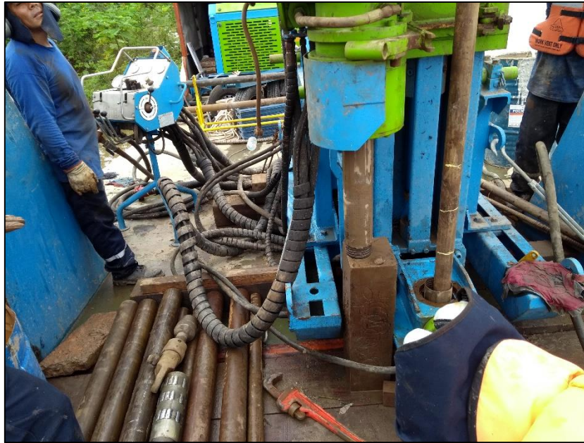
Figura 3.2-19: Perforación diamantina con SPT. SPT-2-PEB Fuente: Elaboración propia. (Mayo 2018).
