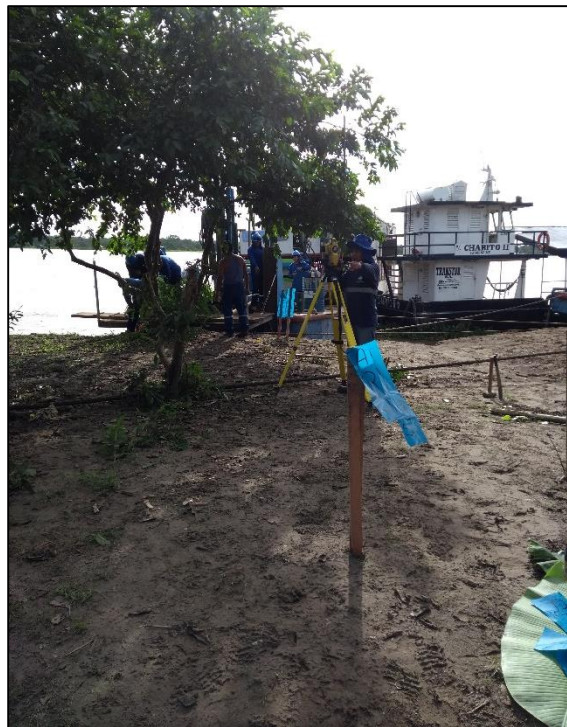
Figura 3.2-15: Levantamiento topográfico de los puntos C-03-SR, DPL-03-SR y SPT-03-SR Fuente: Elaboración propia. (Mayo 2018).
