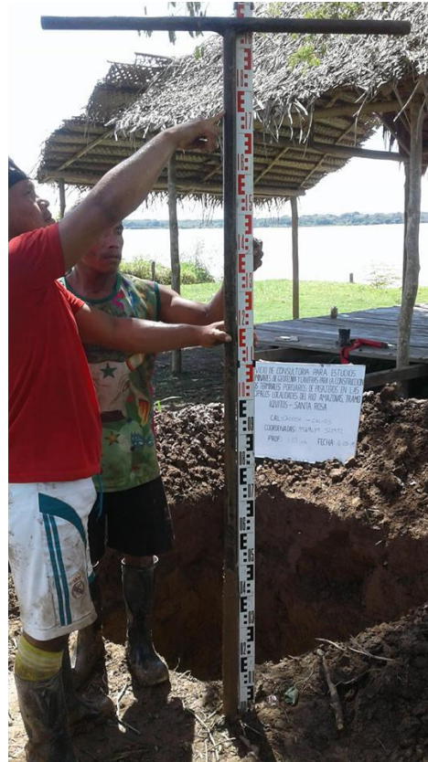
Figura 4.1-48: Excavación de la calicata 03, con ayuda de una barrena manual para llegar hasta los 2.70m de profundidad.
