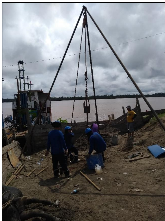
Figura 3.2-24: Ensayo de penetración estándar SPT, SPT-1-SPA Fuente: Elaboración propia. (Mayo 2018).
