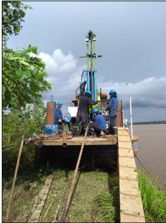
Figura 3.2-20: Perforación diamantina con SPT. SPT-2-PEB Fuente: Elaboración propia. (Mayo 2018).
