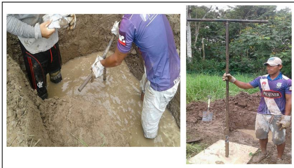
Figura 4.1-46: Excavación de la calicata 01, con ayuda de una barrena manual para llegar hasta los 2.80m de profundidad.
